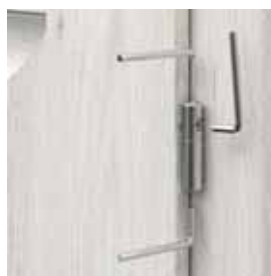
regulacja zawiasów czopowych regulowanych 3D
